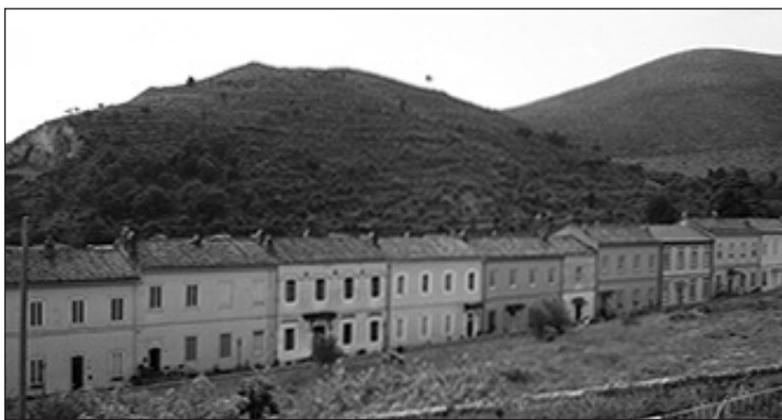
Le case degli operai di San Leucio, oggi di proprietà dei loro discendenti
